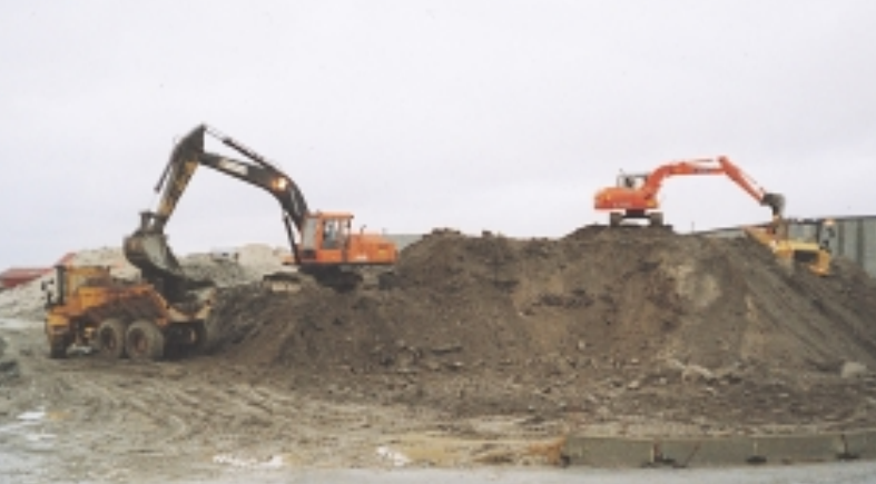
Utbygging av vei/vann/avløp på et nytt industriområde.
