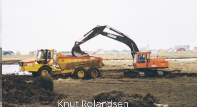
Utbygging av Vannverket i et 70 mål stort myrområde.
